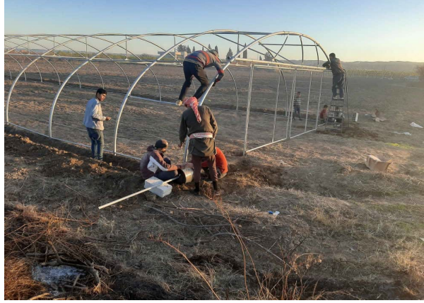
الشكل (1) طريقة إنشاء البيوت المحمية
