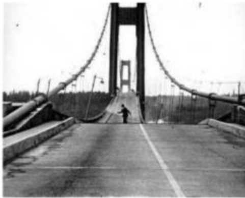
الشكل (1): انهيار جسر تاكوما المعلق في ديترويت عام 1940 بسبب ظاهرة مرونة هوائية تسمى الرجفان.
