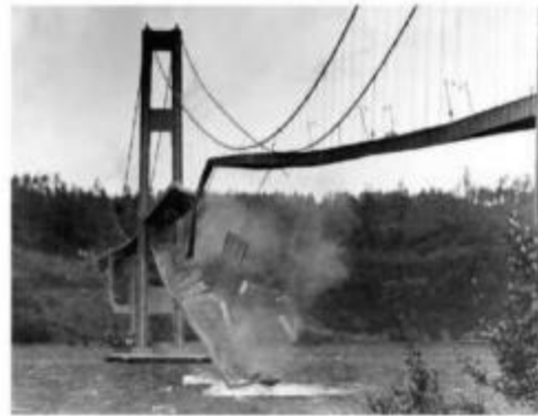
الشكل (1): انهيار جسر تاكوما المعلق في ديترويت عام 1940 بسبب ظاهرة مرونة هوائية تسمى الرجفان.
