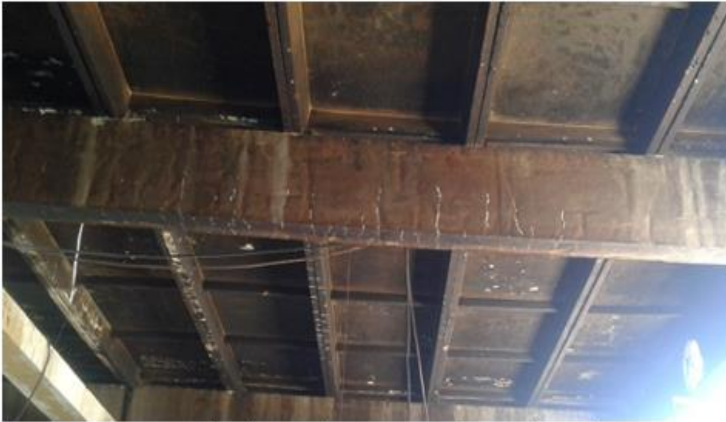
التشوه المرن في العناصر الإنشائية والتشققات الحاصلة نتيجة الانفجار
