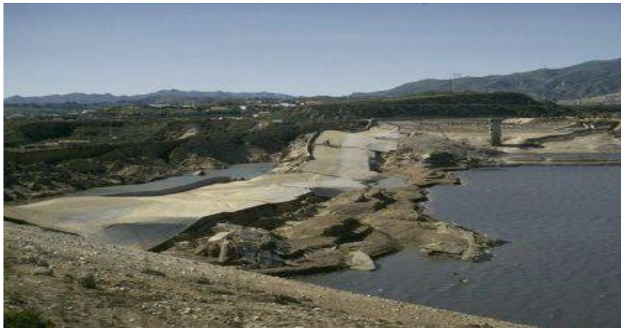
الشكل رقم (3): انهيار سد سان فرناندو بسبب ظاهرة التميع في التربة الناجمة عن الزلازل
