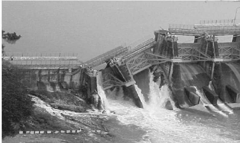
الشكل رقم (4): الانهيار الحاد في سد شيه-كانج نتيجة زلزال تايوان عام (1999) [7].
