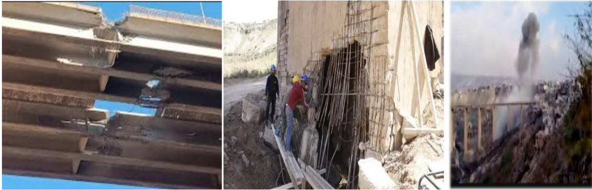
الشكل (7): بعض الأضرار في جسر الرستن
