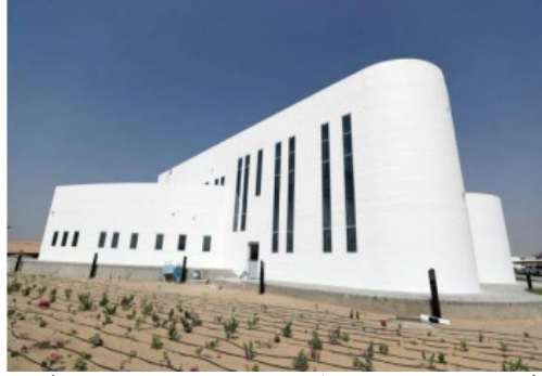
الشكل (7) أول منزل بطابقين في دبي باستخدام الطباعة ثلاثية الأبعاد
