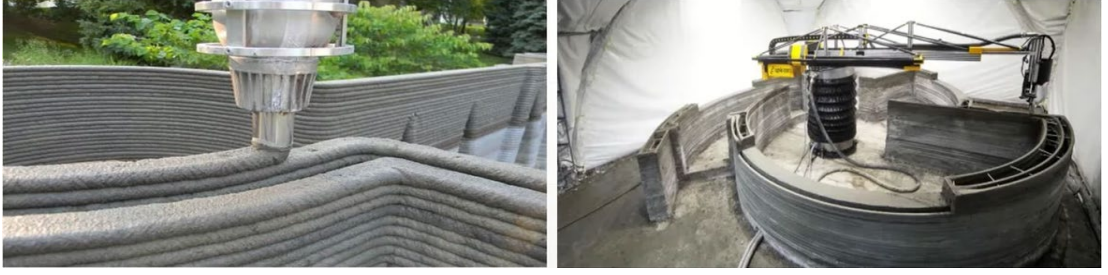
الشكل (2) توضع طبقات الخرسانة باستخدام 3DPrinting
