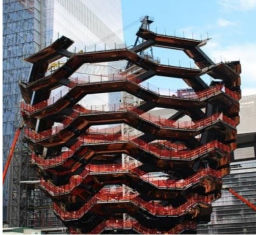
الشكل (4) برج the vessel أثناء الإنشاء.
