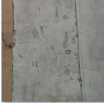
الشكل (17): انكسار الأعمدة البعيدة بتشققات بسيطة.
