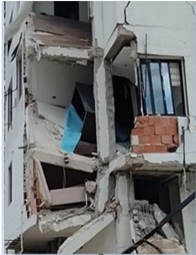
الشكل (30): انهيار العمود الزاوي
