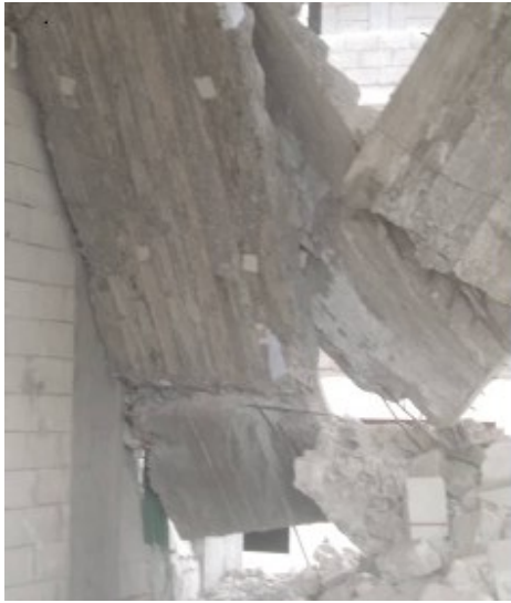
الشكل (36): الانهيار الكامل للدرج
