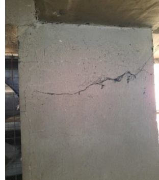
الشكل (17): انكسار الأعمدة البعيدة بتشققات بسيطة.
