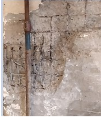
الشكل (21): انهيار جدران القص
