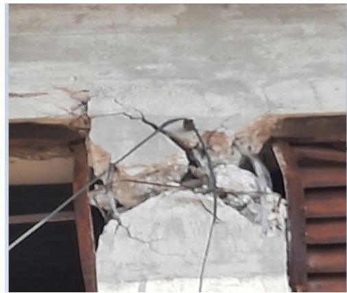
الشكل (13): انهيار العمود
