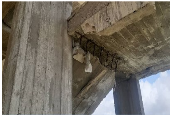
الشكل (33): التفصيلة الحقيقية لتسليح الدرج
