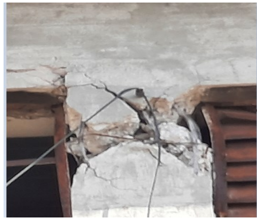
الشكل (13): انهيار العمود
