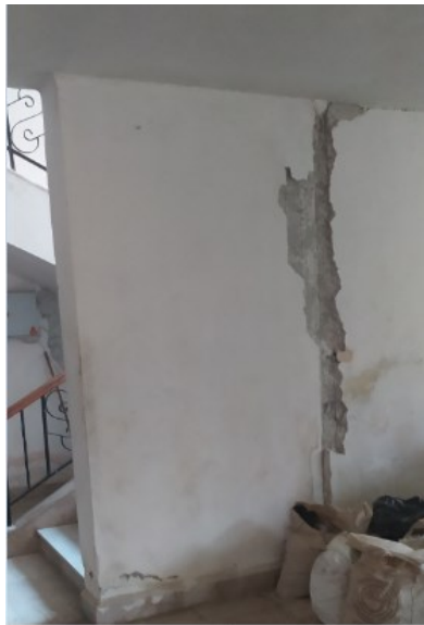
الشكل (24): الانكسار القطري لجدران البلوك الشكل (25): انفصال جدران البلوك عن الأعمدة
