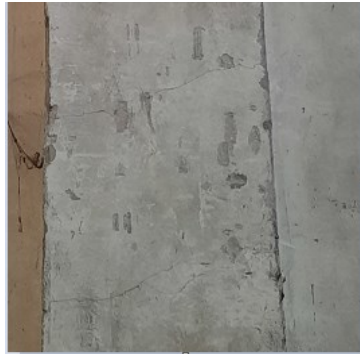
الشكل (17): انكسار الأعمدة البعيدة بتشققات بسيطة.
