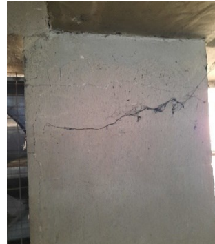
الشكل (17): انكسار الأعمدة البعيدة بتشققات بسيطة.
