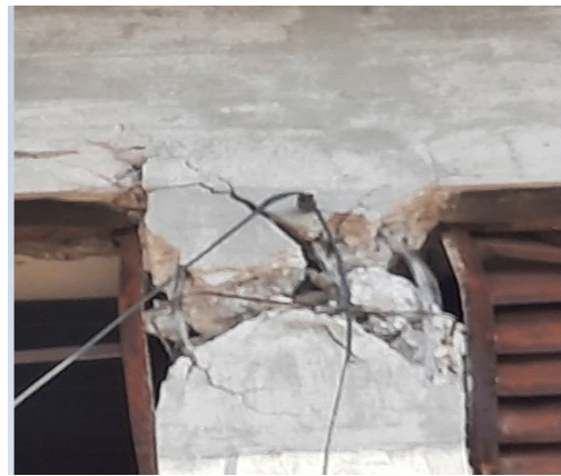
الشكل (13): انهيار العمود
