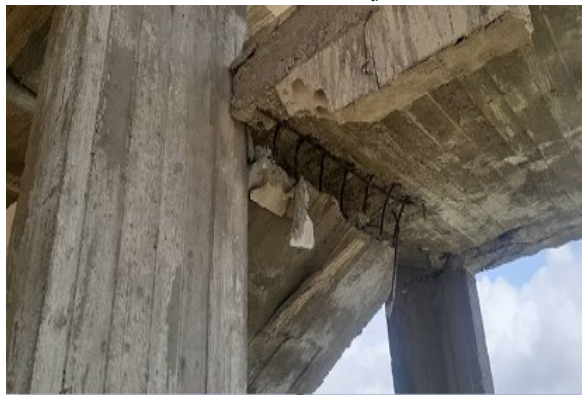
الشكل (33): التفصيلة الحقيقية لتسليح الدرج
