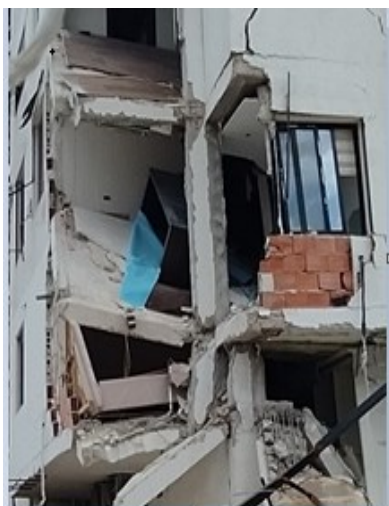
الشكل (30): انهيار العمود الزاوي
