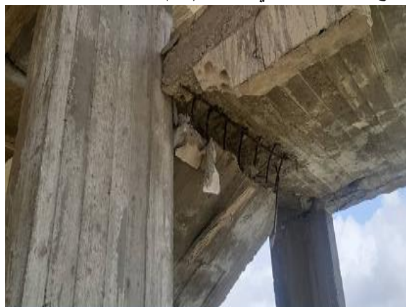
الشكل (33): التفصيلة الحقيقية لتسليح الدرج
