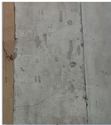
الشكل (17): انكسار الأعمدة البعيدة بتشققات بسيطة.
