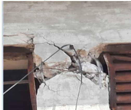
الشكل (13): انهيار العمد
