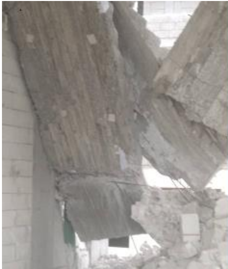
الشكل (36): الانهيار الكامل للدرج
