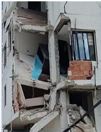
الشكل (30): انهيار العمود الزاوي
