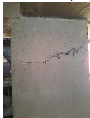
الشكل (17): انكسار الأعمدة البعيدة بتشققات بسيطة.
