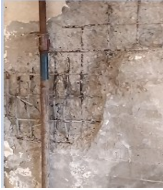
الشكل (21): انهيار جدران القص
