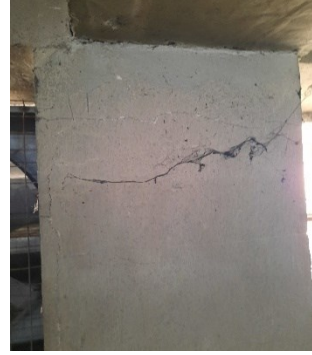
الشكل (17): انكسار الأعمدة البعيدة بتشققات بسيطة.
