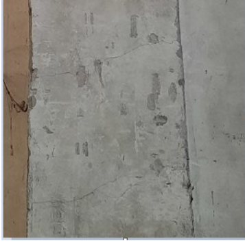
الشكل (17): انكسار الأعمدة البعيدة بتشققات بسيطة.
