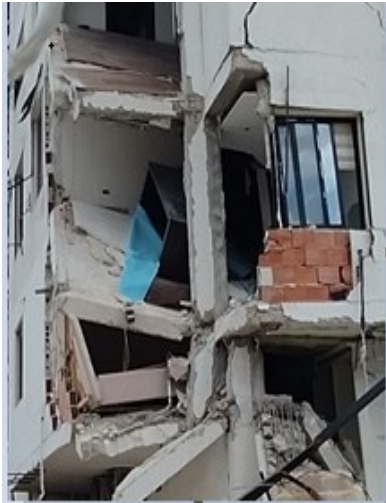
الشكل (30): انهيار العمود الزاوي
