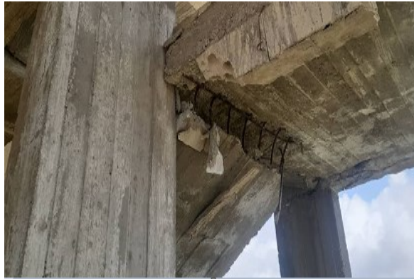
الشكل (33): التفصيلة الحقيقية لتسليح الدرج
