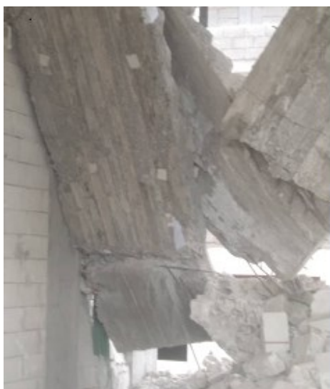
الشكل (36): الانهيار الكامل للدرج
