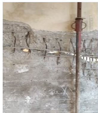
الشكل (20): انهيار جدران القص
