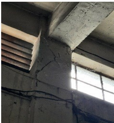
الشكل (14): انهيار القوس
