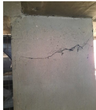
الشكل (17): انكسار الأعمدة البعيدة بتشققات بسيطة.
