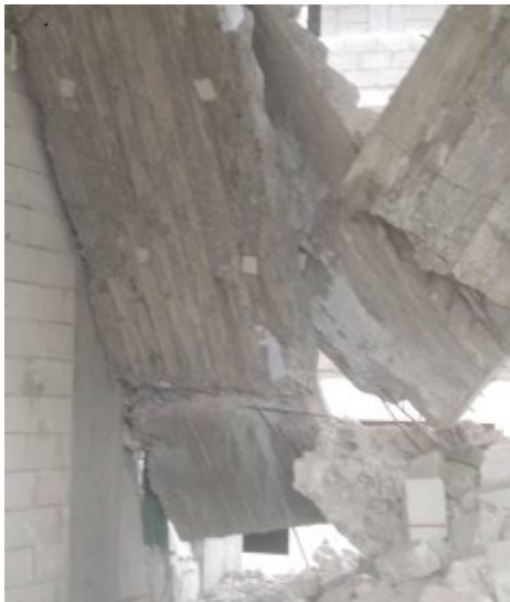
الشكل (36): الانهيار الكامل للدرج
