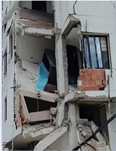
الشكل (30): انهيار العمود الزاوي
