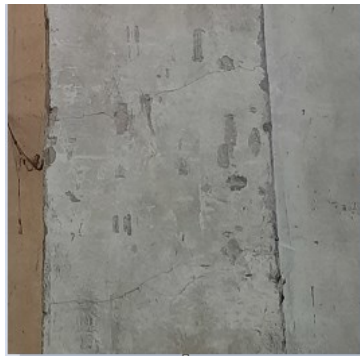
الشكل (17): انكسار الأعمدة البعيدة بتشققات بسيطة.
