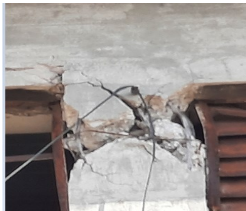
الشكل (13): انهيار العمد
