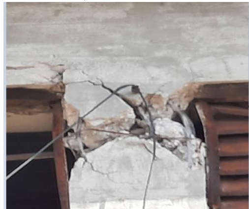
الشكل (13): انهيار العמוד
