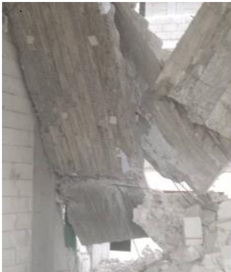
الشكل (36): الانهيار الكامل للدرج
