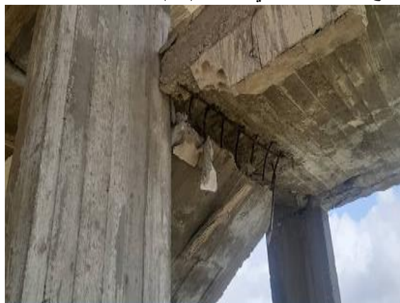
الشكل (33): التفصيلة الحقيقية لتسليح الدرج
