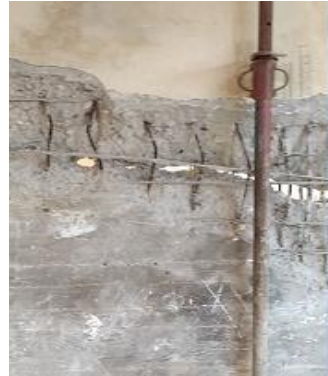
الشكل (20): انهيار جدران القص
