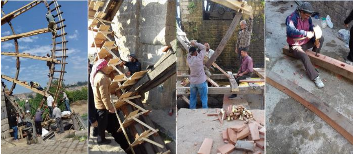
الشكل (6) : صناعة قطع دولا ب الناعورة واستبدال التالف منها يدوياً
