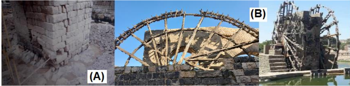
الشكل (8) : الأضرار في النواعير نتيجة (A: حت المياه , B: اهتراء عناصر الدولاب الخشبي)
