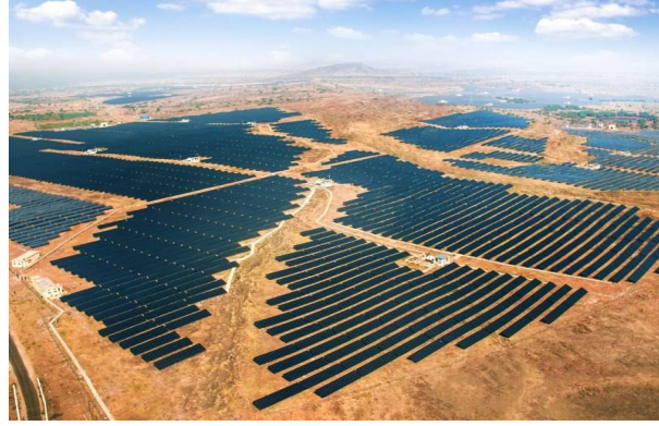
الشكل (4): محطة Bhadla Solar Park
