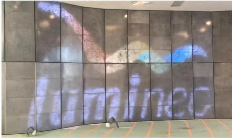
الشكل (5) جدار الخرسانتي الشفاف في قاعة مدخل مقر فينشي الجديد (IMG: Lumineo)
